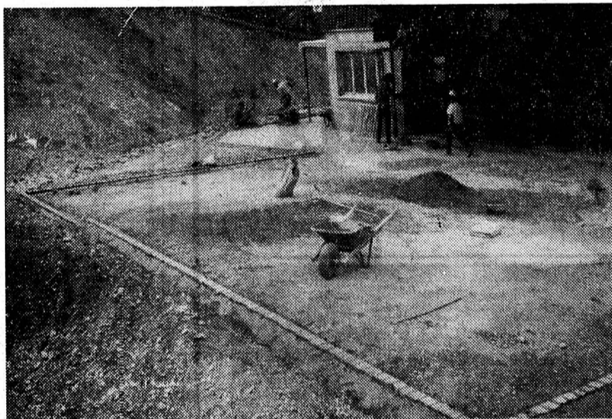
La station de départ en chantier.
