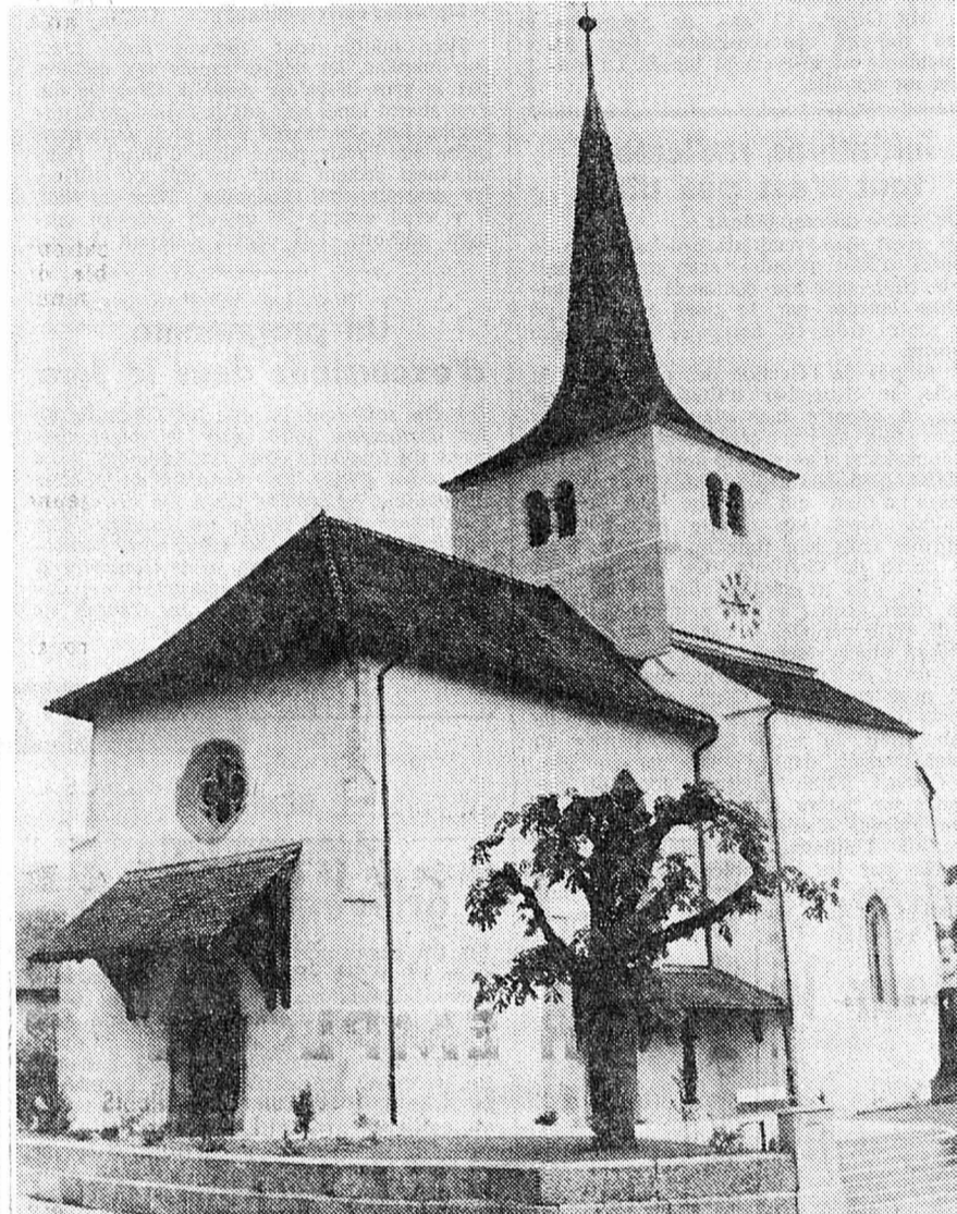
L'église de Fontaines, classée monument historique, telle qu'elle apparaît aujourd'hui après une année et demi de travaux de restauration.
