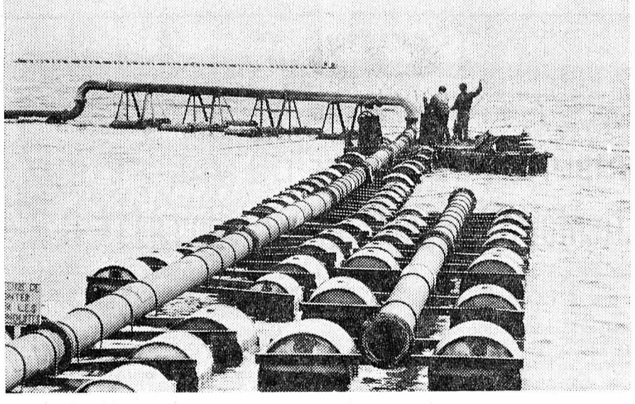
Une imposante installation au large du débarcadère. (Avipress - Périsset)
