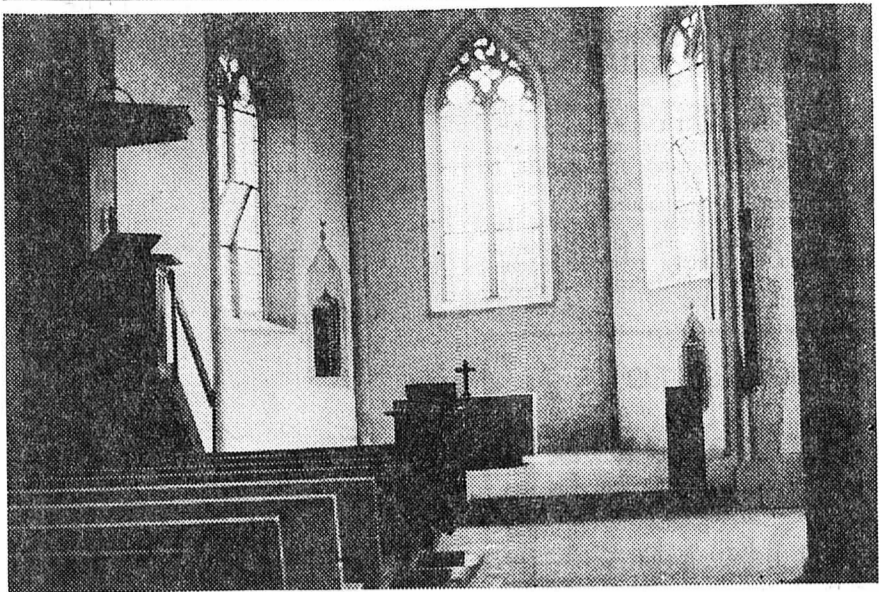
Son plan en forme de croix latine est terminé par un chœur pentagonal. L'expression architecturale, sobre dans la nef et le transept, s'enrichit d'une belle voûte nervurée en forme d'étoile à six branches.
