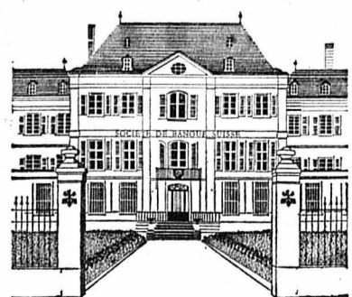
Façade sud Place A.-M.-Piaget
