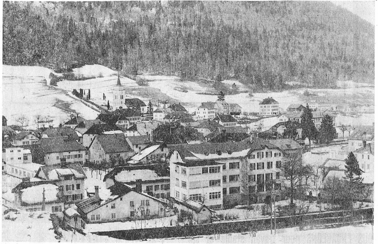
Vue générale du centre du village avec, au premier plan, la fabrique d'horlogerie.
