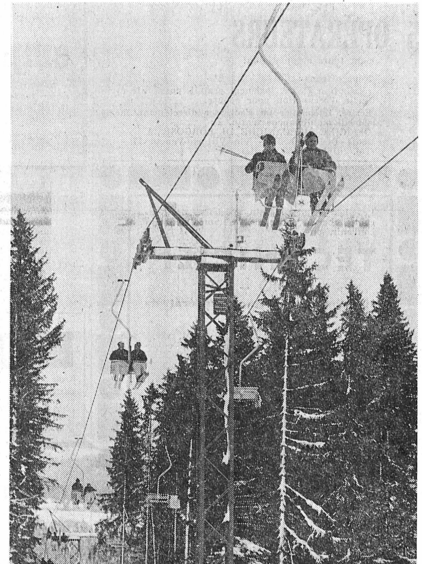
Le télésiège Buttes - la Robella est inauguré aujourd'hui en même temps que tout le complexe de moyens de remontée qui font désormais de Buttes un des paradis jurassiens de ski : télésiège la Robella - le Crêt-de-la-Neige, télésiège de la Combe, d'entraînement à la Robella, télésiège des Couellets. Et des pistes, magnifiquement entretenues, pour toutes les catégories de skieurs.
