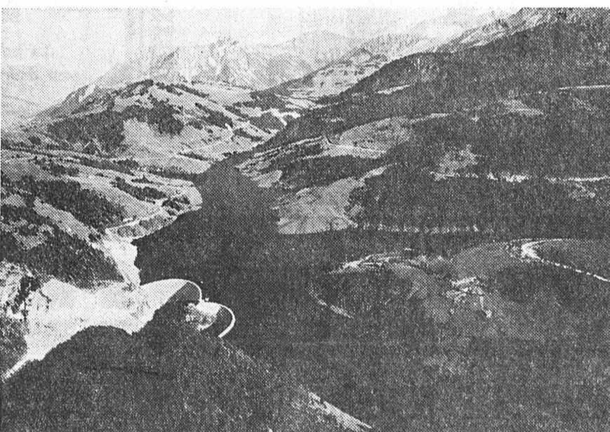
Le lac artificiel de l'Hongrin et son barrage à double voûte prenant appui, au centre, sur un éperon rocheux. Il se trouve dans la région avoisinant le col des Mosses entre Aigle et Château-d'Oex, sur territoire vaudois. Le barrage retient un volume utilisable de 52 millions de mètres cubes d'eau.
