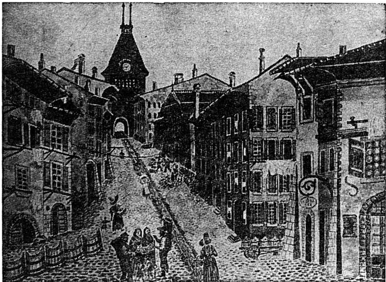
La Tour des Chavannes et sa rue, avant 1867.
