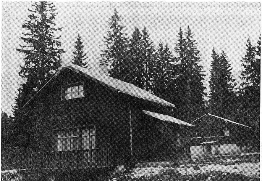
Le chalet de la Gentiane, appartenant au Ski-club des Cernets et Verrières, que les marcheurs découvriront en descendant du Crêt-du-Pussin. A l'arrière-plan, le bâtiment abritant des dortoirs et le local de fartage. (Avipress - Fyj)
