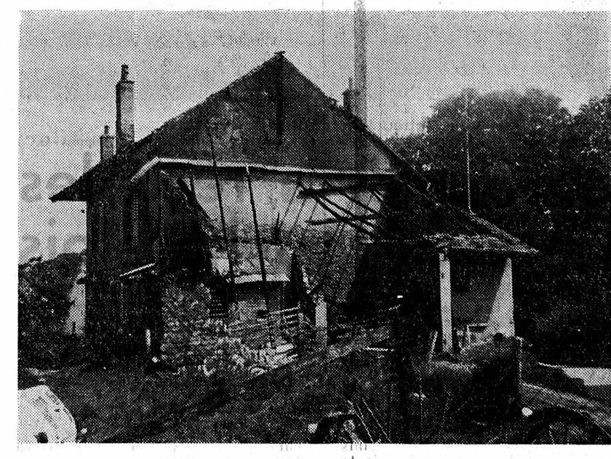
Les dégâts causés par le feu sont importants. (Avipress - Périsset)
