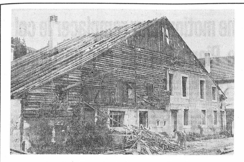
La démolition de la ferme des Girardet... (Photo Avipress - Bernard)
