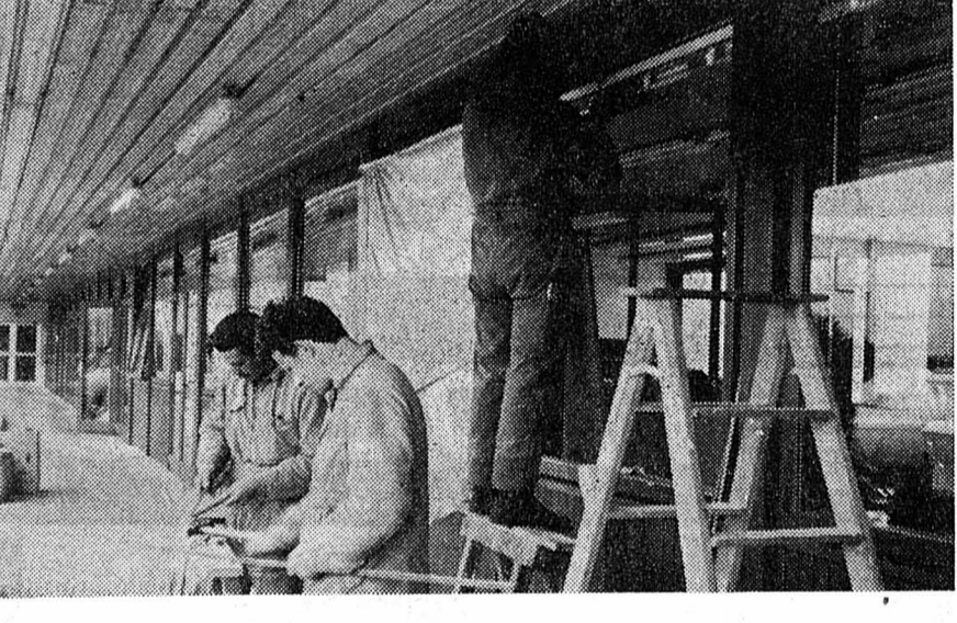
Des ouvriers remplacent les baies vitrées soufflées par l'explosion. (Avipress - Paché)
