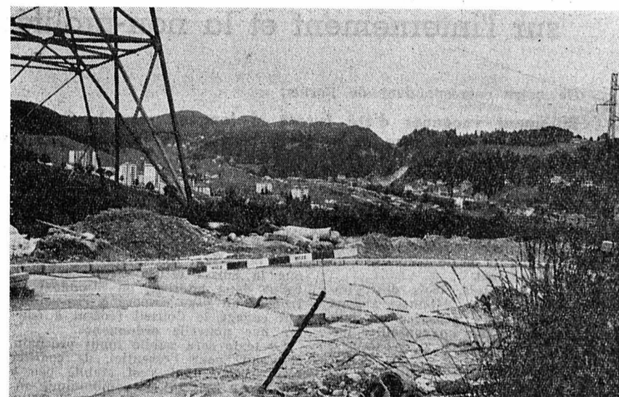
(c) Les travaux de construction de la nouvelle route des Primevères avancent rapidement. Actuellement, tout le tronçon est déjà garni de plaques isolantes. De plus, comme le montre notre photo, la chaussée a déjà été aplani par des rouleaux compresseurs. Lorsque le tapis bitumeux aura été posé, la ville possèdera une excellente route qui reliera la Jaluse et le quartier du Communal. (Avipress - Cy)
