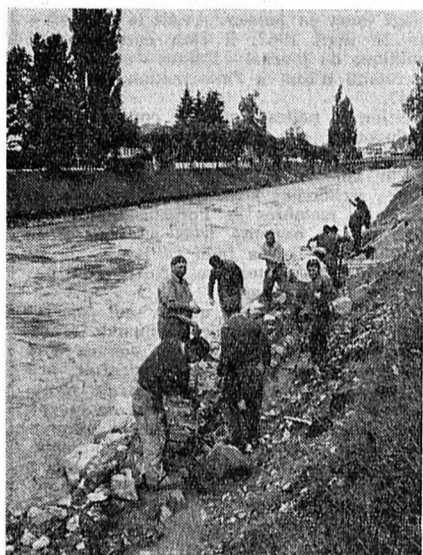
La Broye charrie des débris et ces ouvriers ferment une tranchée où l'on vient de poser un collecteur d'égout.
