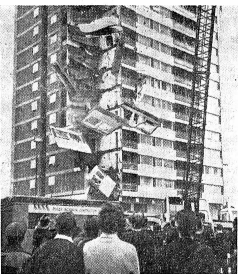
L'immeuble après la catastrophe.
