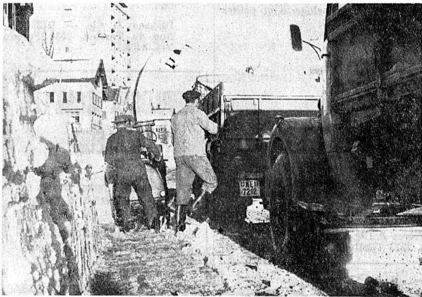
Les camions attendent à la rue Girardet et la fraiseuse les remplit.
