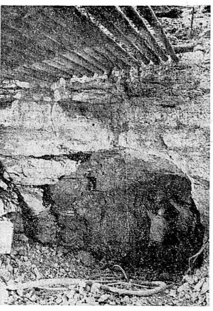
Quatre ou cinq fois par jour, une explosion fait progresser le percage de la galerie.
