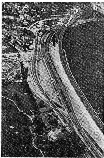
Le nouveau pont de Melide, sur le lac de Lugano, un des plus beaux tronçons de la Nationale 2 reliant Bâle à Chiasso. A gauche du pont, le parc abritant la « Suisse miniature ». (Photo RIA)
