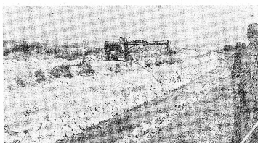
ENROCHEMENT — Les travaux sont en bonne voie (Avipress - Pache)
