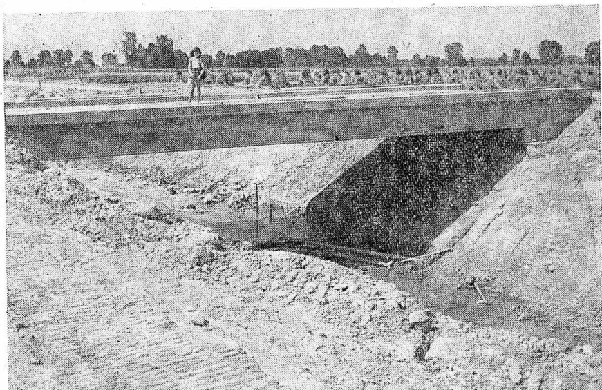
OUVRAGE — Un nouveau pont enjambe de canal de l'Arbogne
