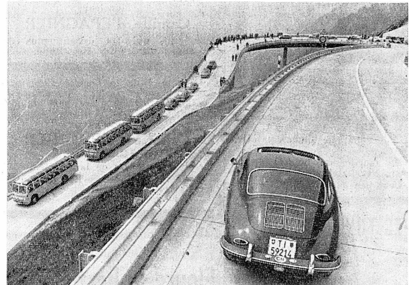
Image presque irréelle dans ce décor de montagne : la nouvelle Tremola qui a été inaugurée vendredi dernier. Cette réalisation spectaculaire d'une longueur de 8 kilomètres et qui atteint huit mètres de largeur a coûté près de 60 millions de francs.
