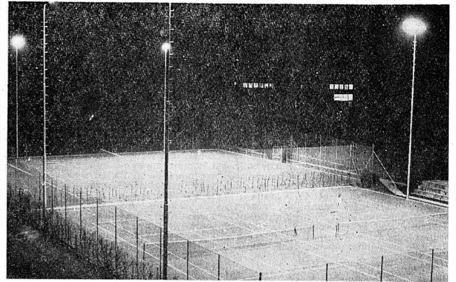
ECLAIRAGE — Les nouvelles installations (Avispress - Guggisberg)
