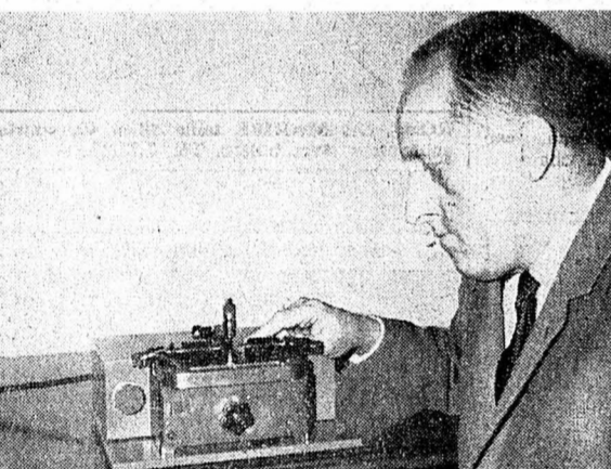
Médaille d'or : M. Paul Pétermann, de Bienne, pour une machine semi-automatique à violer les spiraux d'horlogerie. (Avipress - Guggisberg)
