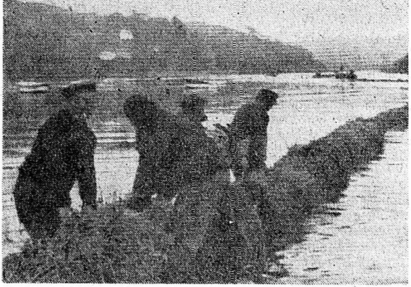
Pour freiner la marée noire qui envahit les côtes bretonnes et menace de détruire les parcs à huîtres, des pêcheurs ont aménagé ce barrage, fait de branchages et long de 200 mètres, à Beg-Huet à quelques kilomètres de Lanion, dans le département des Côtes-du-Nord. (Téléphoto AP)
