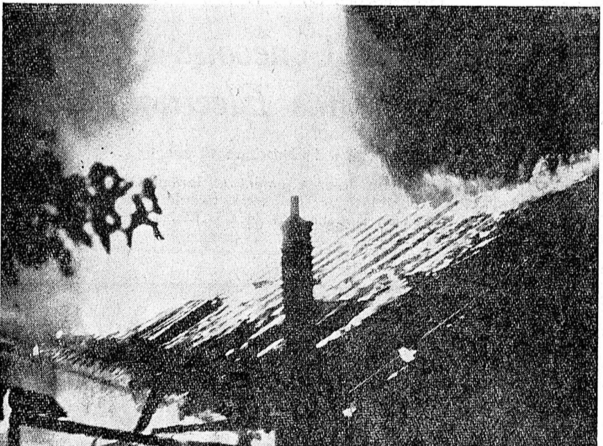
La toiture est la proie des flammes et commence à s'écrouler. (Avispress - D. E.)
