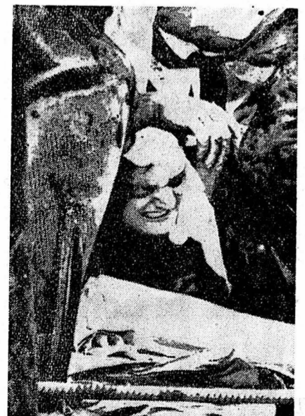
Un des ouvriers coincés entre des blocs de ciment et d'acier. (Téléphoto AP)
