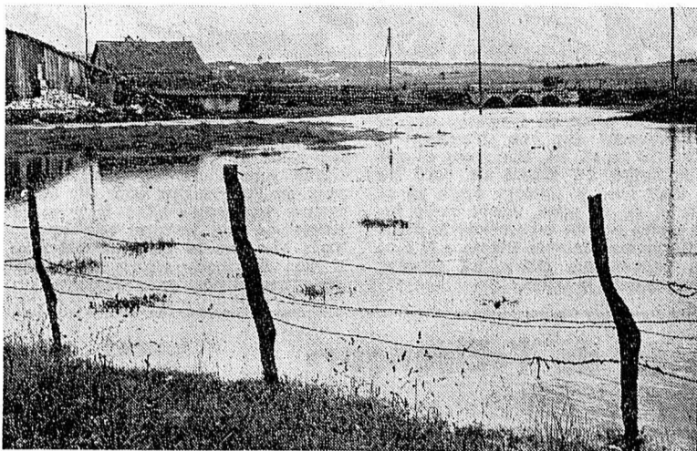
A son passage à Courtedoux, le Creugenat cause des inondations
