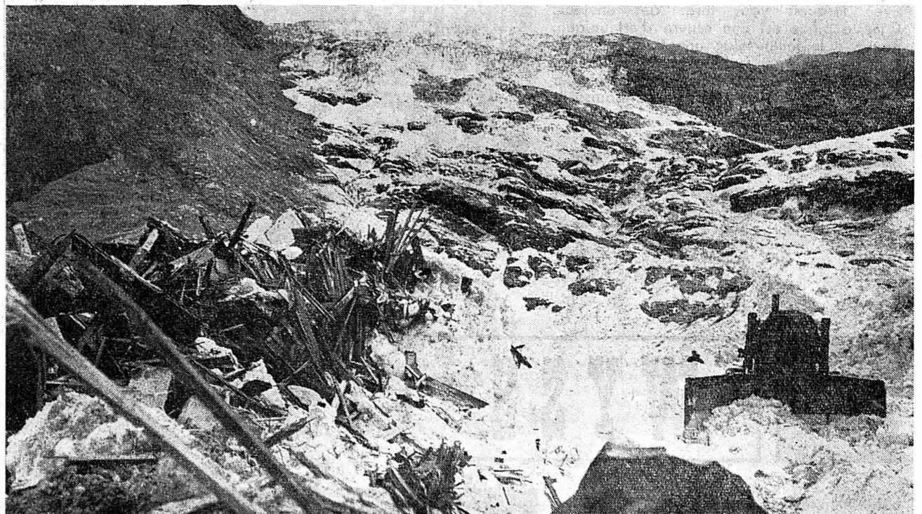
C'est toute l'explication de la catastrophe: des bâtiments forcément légers réduits à l'état de petit bois par une coulée de glace que rien au monde n'aurait pu stopper.
