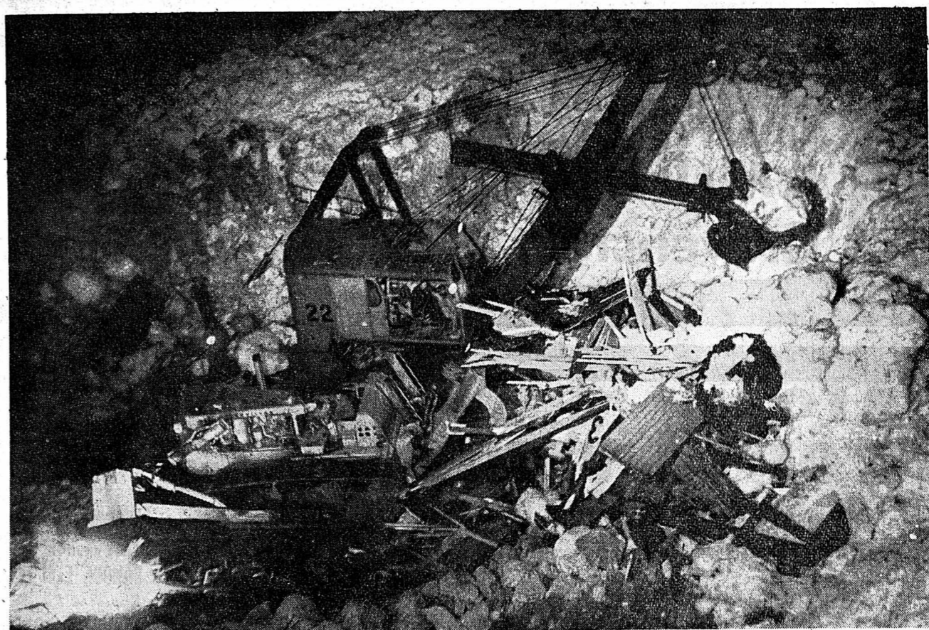
Dans la plaine lunaire de Mattmark, sous les projecteurs, c'est la quête inlassable des sauveteurs, dans le fracas des moteurs des pelles mécaniques.
