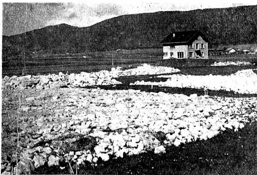
Près de Savagnier, on construit actuellement, sur de bonnes terres cultivables, des bâtiments destinés à l'élevage des poulets industriels!
