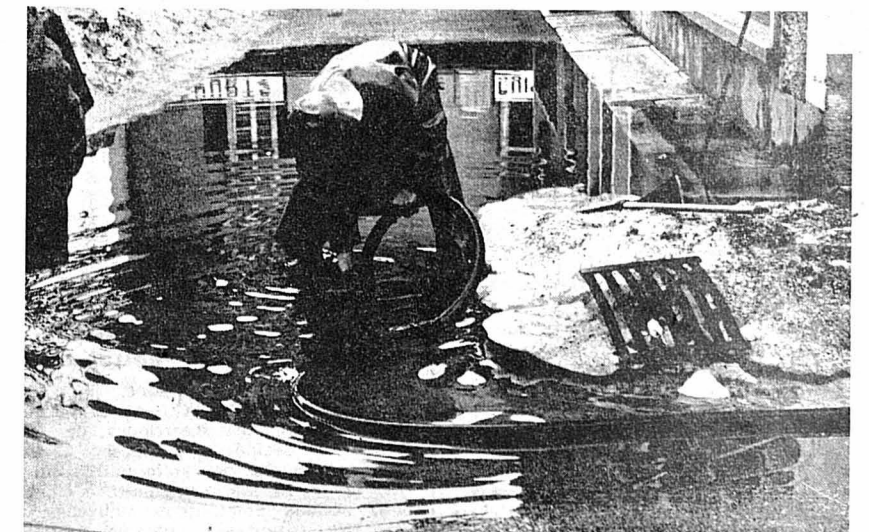
(c) Lundi après-midi, un égout bouché par de la glace a provoqué une inondation devant un magasin de... sport à la Grand-rue à Fleurier. On est parvenu à déboucher cet égout avec une lance branchée sur une borne d'hydrant. L'eau combat l'eau... ce n'est pas l'une des plus piquantes fantaisies du dégel !
