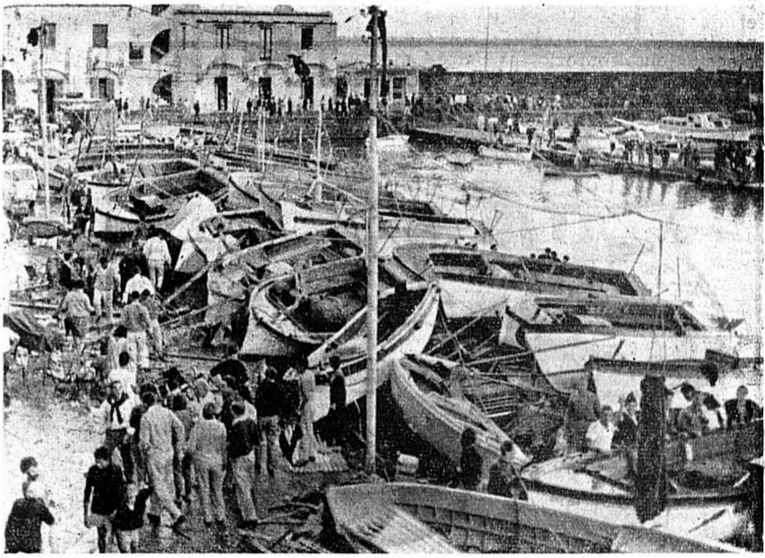
Un pêcheur tué, trente personnes blessées, des maisons et des barques de pêcheurs endommagées: c'est le bilan des dégâts causés par une tempête presque un cyclone...
