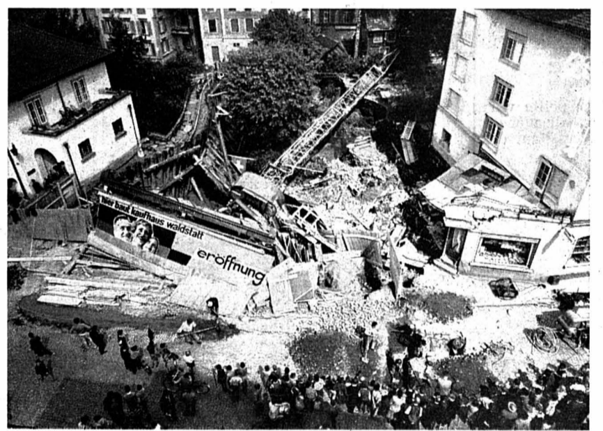
Une grue renversée, des maisons endommagées, mais heureusement pas de morts, ni de blessés: tel est le bilan de ce spectaculaire accident.
