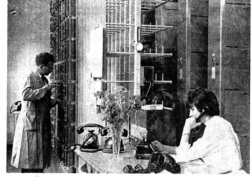
(sp) Depuis le début de cette semaine, un nouveau central téléphonique est en service à Couvet. Voici l'intérieur de la station où une téléphoniste appelle les abonnés pour le contrôle des lignes pendant qu'un technicien effectue les dernières corrections au réparateur principal.
