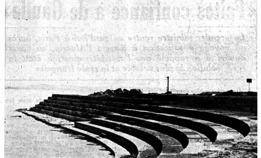
C'est ainsi que se présentent les gradins de la nouvelle plage de Serrières, au sud de la fabrique de tabacs. Les travaux d'aménagement des pelouses vont se poursuivre afin que les baigneurs disposent cet été d'un coin bien à eux.
