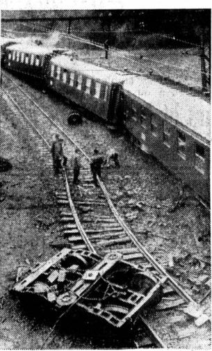
Notre photo montre les wagons sortis des rails et, au premier plan, un boggie qui s'est détaché de l'une des voitures. Les rails ont été déplacés et l'on reconnaît facilement l'endroit privé de boulons.
