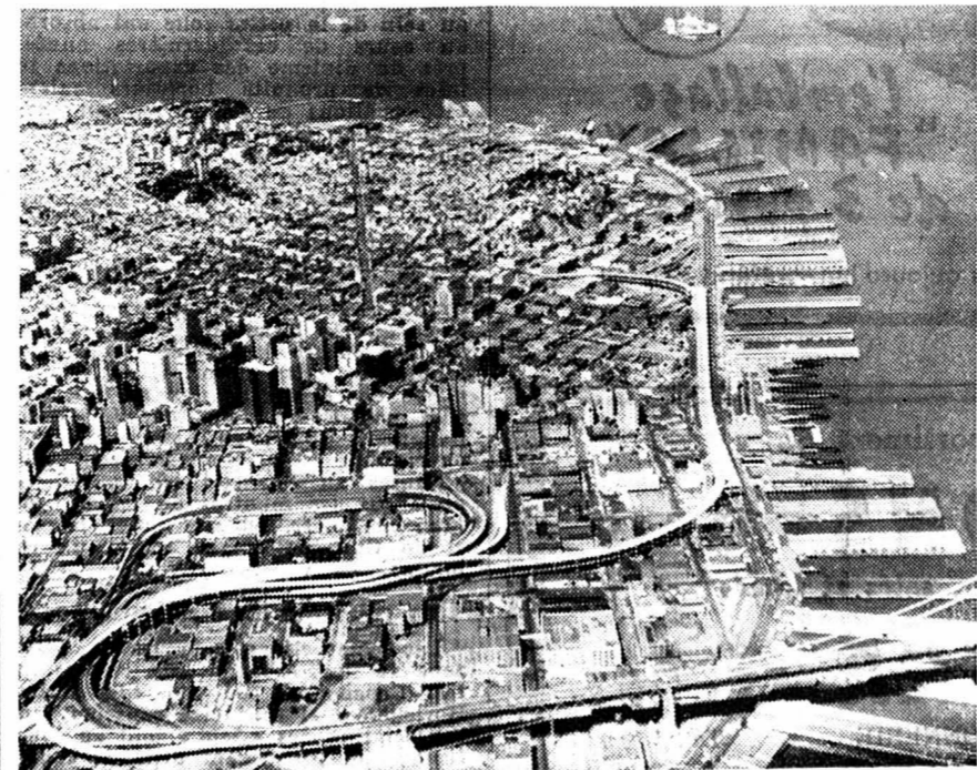
Notre photo montre une vue aérienne d'une gigantesque voie de dégagement à San Francisco, qui passe au-dessus des rues et garantit au flux et reflux des autos une circulation sûre et sans croisements.
