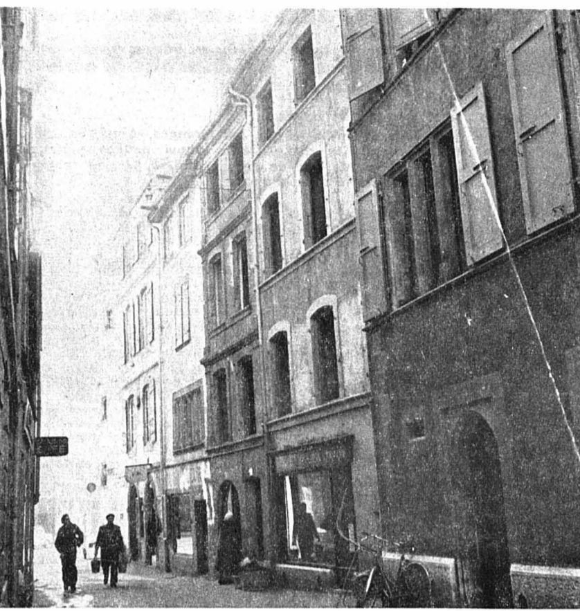
Voici les deux immeubles (sans volets) qui vont être démolis à la rue de Flandres et qui seront reconstruits, les façades gardant leur style.
