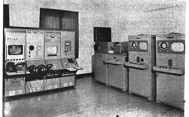
Les nouvelles installations de l'émetteur de la Dôle. A droite: le convertisseur utilisé pour transformer l'image française de 819 lignes en image suisse à 625 lignes.
