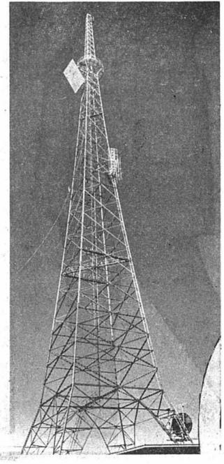
Le mât de 125 m. érigé à la Dôle. On voit en haut le plan métallique qui réfléchit vers le sol le faisceau d'ondes émises par le relais français de Cuiseaux. En bas à droite, l'écran mobile qui sert à la liaison avec le car de reportage du programme romand.
