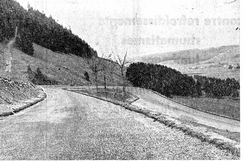
Entre la Côte-aux-Fées et les Verrières, la correction de la route est terminée. Les virages ont été élargis et bitumés.
