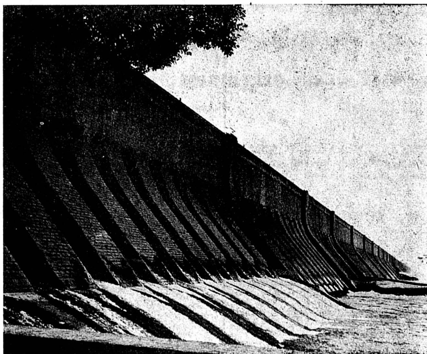
Une vue impressionnante de la digue
