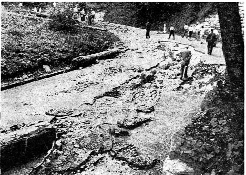
Le virage de la Sagneule a été labouré par le flot de boue et de pierres. Les pavés ont été enlevés. (Phot. J. C. Zschau, Neuchâtel).
