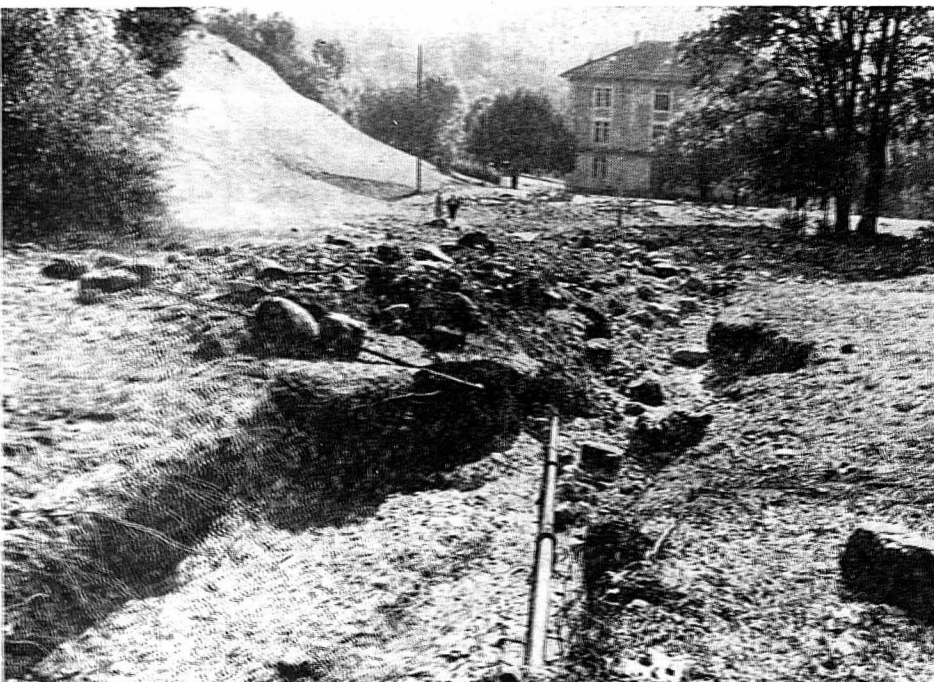
Débouchant de la Mauvaise-Combe, le torrent de boue est venu recouvrir le terrain de gymnastique de Rochefort et envahir le sous-sol (où se trouve la grande salle) du collège.
