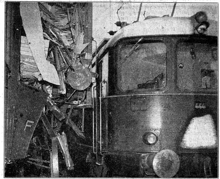
La voie sud n'a été obstruée à aucun moment. C'est pour cela que le trafic a pu être maintenu sans transbordement et sans gros retard. Les convois - même les directs - passaient cependant par la gare de Bevaix au ralenti.
