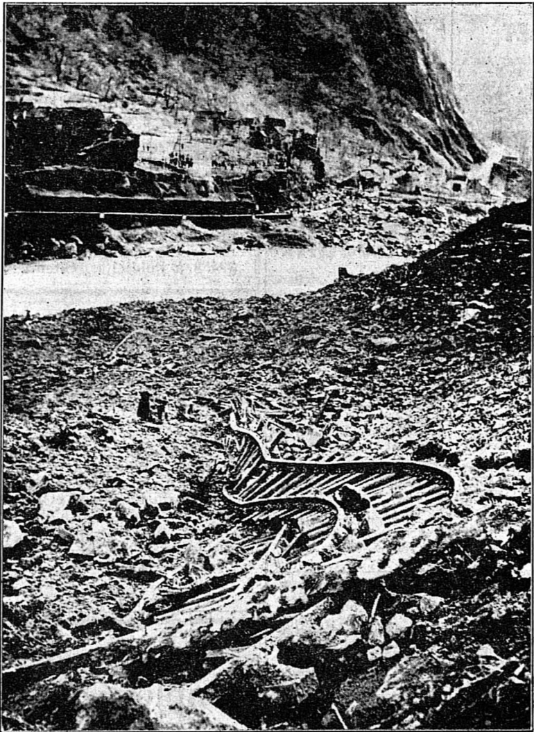
Comme nous l'avons annoncé, un nouvel éboulement s'est produit mardi dans la région de Domodossola. La route de la vallée et la voie ferrée du Simplon ont été obstruées et la circulation coupée, entre Varza et Preglia. On évalue à un million de mètres cubes les matériaux qui sont descendus de la montagne et qui ont emporté la maison du garde-barrière de Preglia. Celui-ci, sa femme et ses trois enfants ont été tués.
