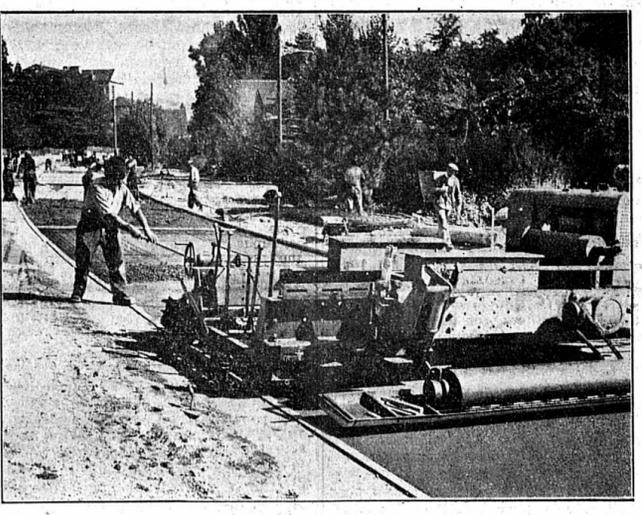
La machine, montée sur rails, qui permet de « vibrer » et d'aplanir de 600 m<sup>2</sup> par jour.
