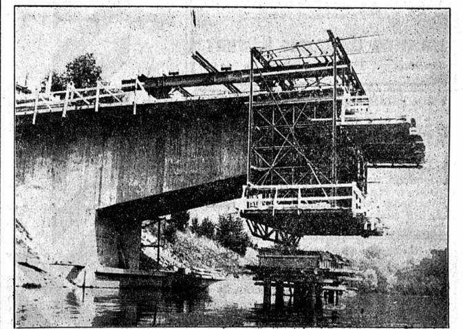
Les Allemands construisent un nouveau pont sur le Neckar, dans le Wurtemberg. Grâce à l'emploi de presses hydrauliques, les arches prennent corps insensiblement, au rythme de trois mètres par semaine. Le pont sera terminé en novembre.
