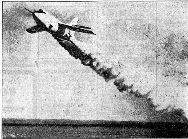
Cet avion-fusée américain, le «Skyrocket» fabriqué par les usines Douglas, a été lâché par un bombardier à une altitude de 10,000 mètres. Ses quatre fusées entrèrent alors en action et l'avion atteignit en l'espace de trois minutes la hauteur de 23,000 mètres. En ce laps de temps, il brûla trois tonnes de carburant.
