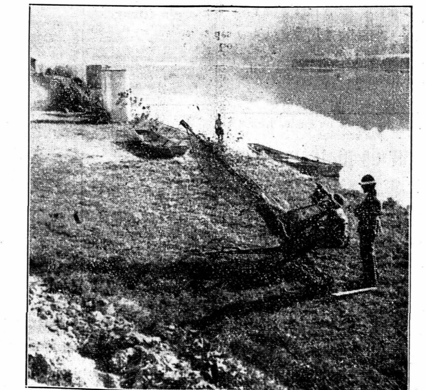
Le pont sur l'Aar, près de Niederried, a pu être franchi mardi matin par le bat. car. 2. Pour permettre le passage du reste du régiment, il a été gardé pendant toute la journée par la compagnie de grenadiers du rgt. 8 et par des pièces de D.C.A., camouflées sur les bords de la rivière.
