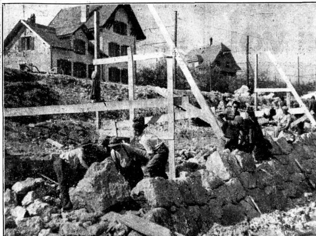
L'élargissement du tournant de la route, au carrefour du pré Landry, à Boudry, nécessite la construction d'un mur de soutènement dont la base repose dans le lit de l'Areuse.
