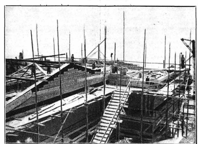
Les travaux de maçonnerie sont bientôt terminés à Champ-Bougoin. On voit, à gauche, la charpente métallique qu'on installe au-dessus de la chambre des filtres.
