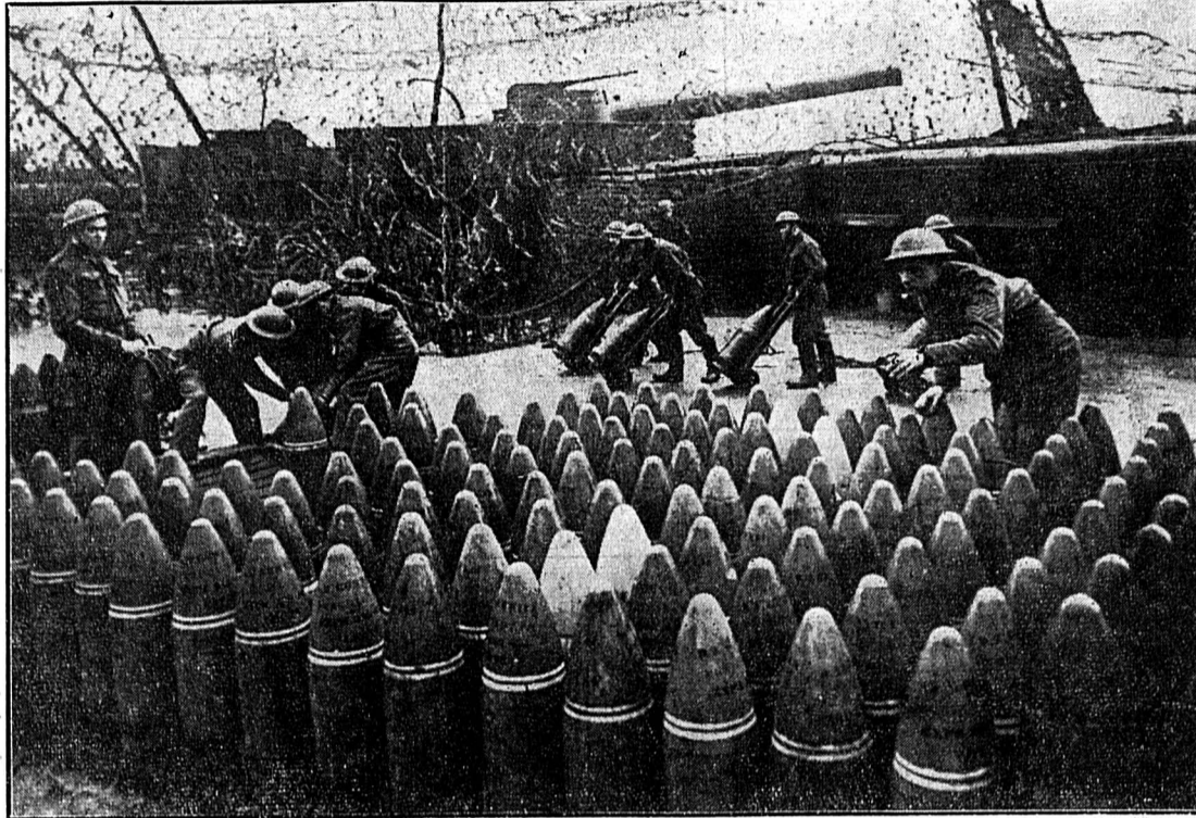
Les côtes anglaises voient chaque jour augmenter leurs fortifications. Dans l'une des batteries côtières, un chargement de munitions vient d'arriver. Les obus sont vérifiés avant d'être emmagasinés dans des soutes souterraines aménagées spécialement.
