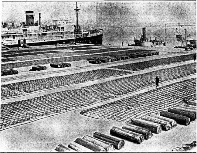
Ces filets, tendus à l'avant des ports pour en barrer l'accès aux sous-marins ennemis, doivent être retirés de l'eau périodiquement. Après vérification et remise en état, on les fait sécher au soleil avant de les immerger à nouveau.
