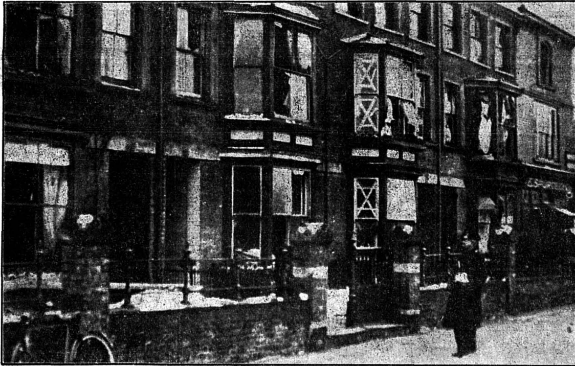
Sur la côte anglaise, une mine ayant heurté une digue fit explosion et détériora sérieusement cette dernière. Dans un rayon d'un kilomètre les vitres des maisons volèrent en éclats. — Voici des fenêtres endommagées par l'explosion.
