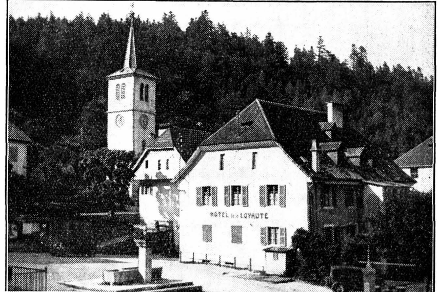
L'église et le fameux hôtel de la Loyauté, aux Ponts-de-Martel, se détachent sur un fond bien jurassien.
