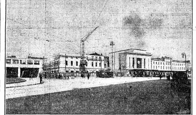
L'état actuel des travaux de construction de la nouvelle gare Cornavin à Genève. La halle centrale et l'aile gauche seules sont ouvertes au public. Le buffet va être incessamment démoli et tout de suite après commenceront les travaux pour relier l'aile droite à l'aile gauche.
