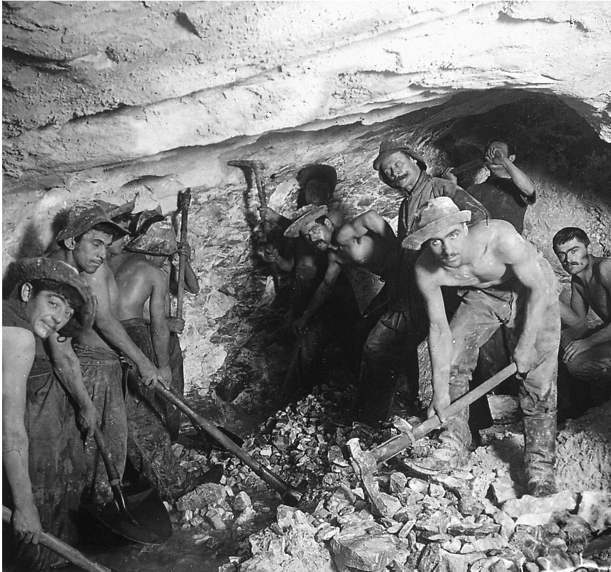
Abb. 16: Mineure bei der Arbeit im Simplontunnel (Sammlung Georges Tscherrig, Brig-Glis)
