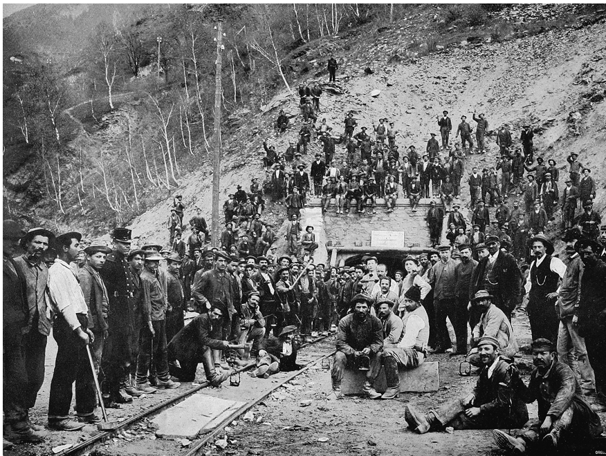
Abb. 13: Arbeiter vor dem Simplontunnel 1899 (Sammlung Georges Tscherrig, Brig-Glis)
