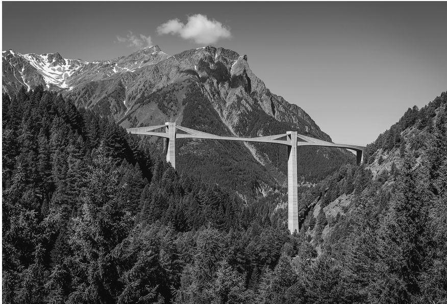
Abb. 24: Die moderne Simplonpassstrasse mit der 1976–1980 erstellten neuen Ganterbrücke (Foto: Christian Pfammatter)
