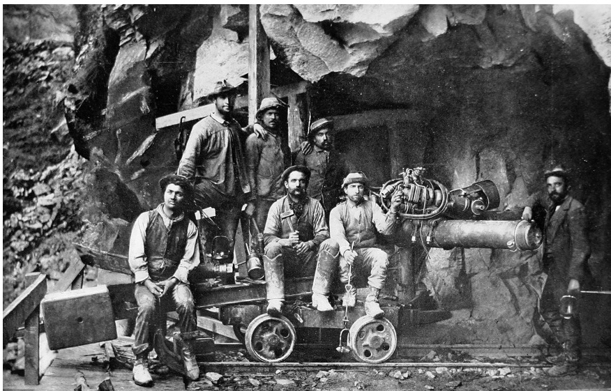
Abb. 14: Arbeiter auf einer Bohrmaschine von Maschinenbauingenieur Alfred Brandt (Sammlung Georges Tscherrig, Brig-Glis)
